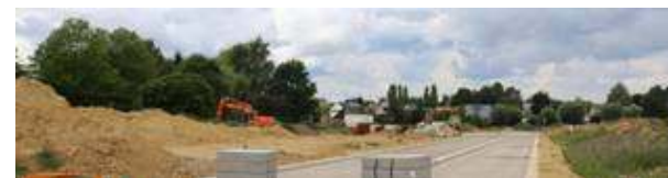
In de verkaveling aan de Stichelstraat wordt de nieuwe weg aangelegd. - Mozkito
